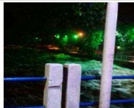
Cachoeiras de Guapimirim ontem a noite. Faltou pouco para a água passar por cima da ponte.
